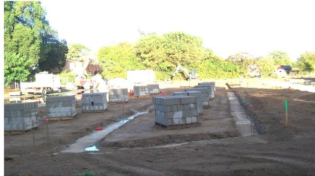
En septembre, les maçons réalisent l'excavation et coulent les fondations. Après séchage des fondations, les premières palettes de parpaings arrivent sur le terrain.
