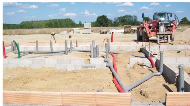
Les fourreaux recevant les câbles électriques et téléphoniques, les gaines pour les arrivées d'eau et le raccordement à l'égout sont installés.
