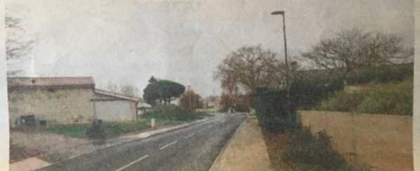
L'enfouissement des lignes route des Acacias. PHOTO P.P.
