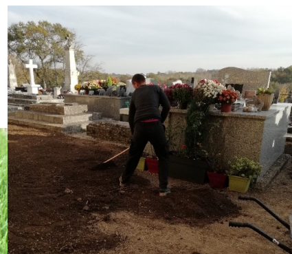
2. Apport de terre végétale et nivelage — 8 cm d'épaisseur
