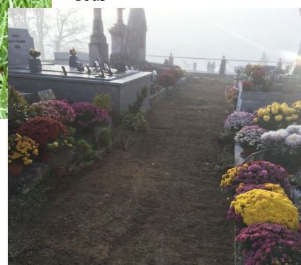
3. Engazonnement et compactage
