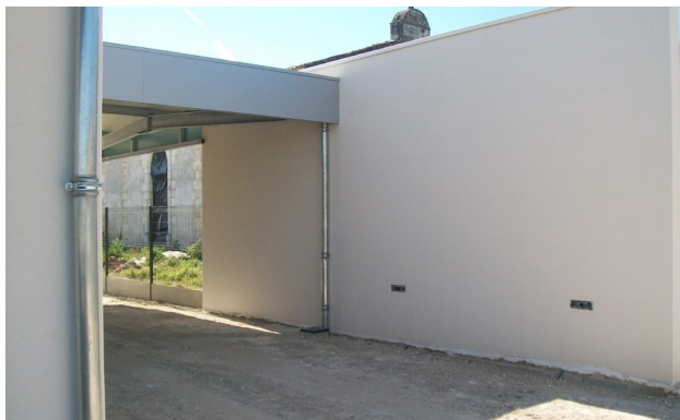
Entrée façade principale
