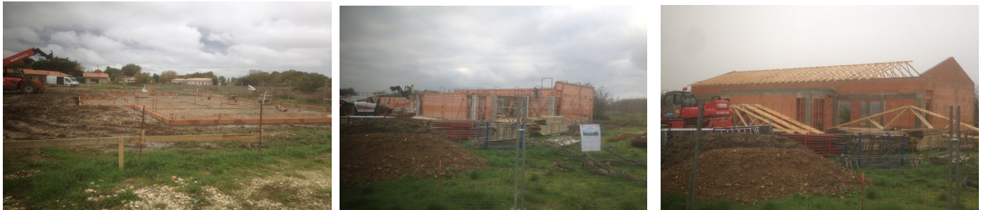
Démarrage chantier : implantation, élévation, couverture
