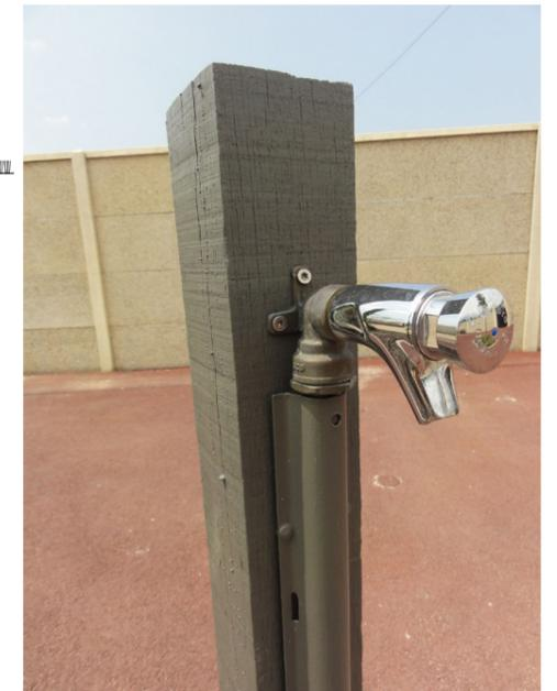
Exemple de fixation robinet sur support poteau bois peint avec goulotte de couverture de la canalisation
