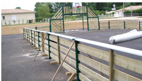
Montage de la structure du city stade
