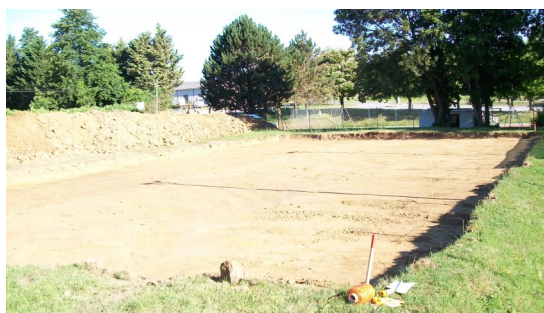
Juin - travaux de terrassement de la plateforme
