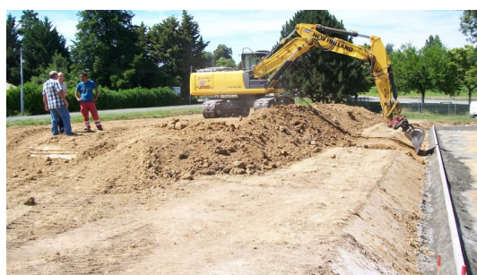
Aménagement des abords
