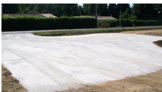
Aménagement du parking du city stade
