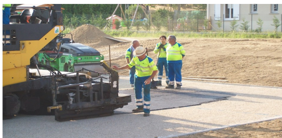
Pose de l'enrobé de la plateforme
