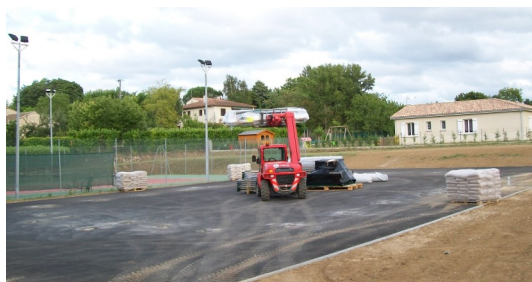
Mise en enrobé de la plateforme et stockage des éléments de la structure du city stade
